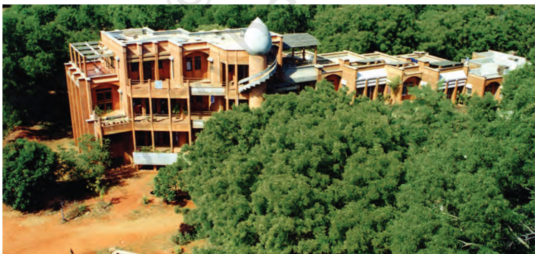
चित्र 1.19 — ऑरोविले में ऑरोविले अर्थ इंस्टीट्यूट (जो मृदा वास्तुकला के लिए यूनेस्को से मान्यता प्राप्त है) द्वारा निर्मित एक सामुदायिक भवन। यह आधुनिक भवन विशेष तकनीकों का उपयोग करके मृदा से निर्मित किया गया है।
